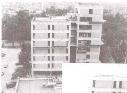
Estado actual de la Torre de Investigación
