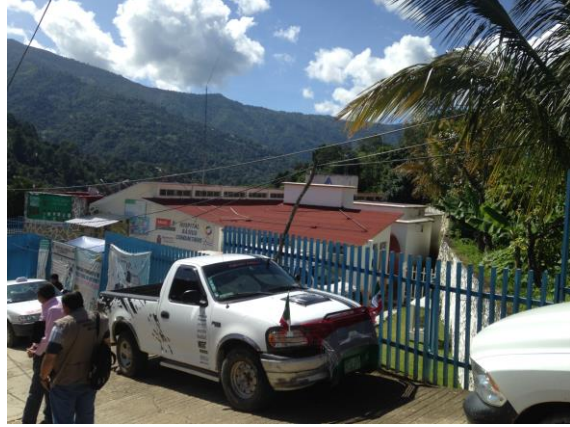
Hospital Básico Comunitario, Malinaltepec, Guerrero.
