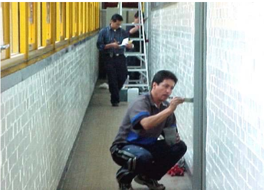
Nuestro trabajadores en labores de mantenimiento
